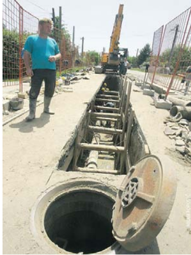
Слика бр.5: Изградња канализационе мреже 25
